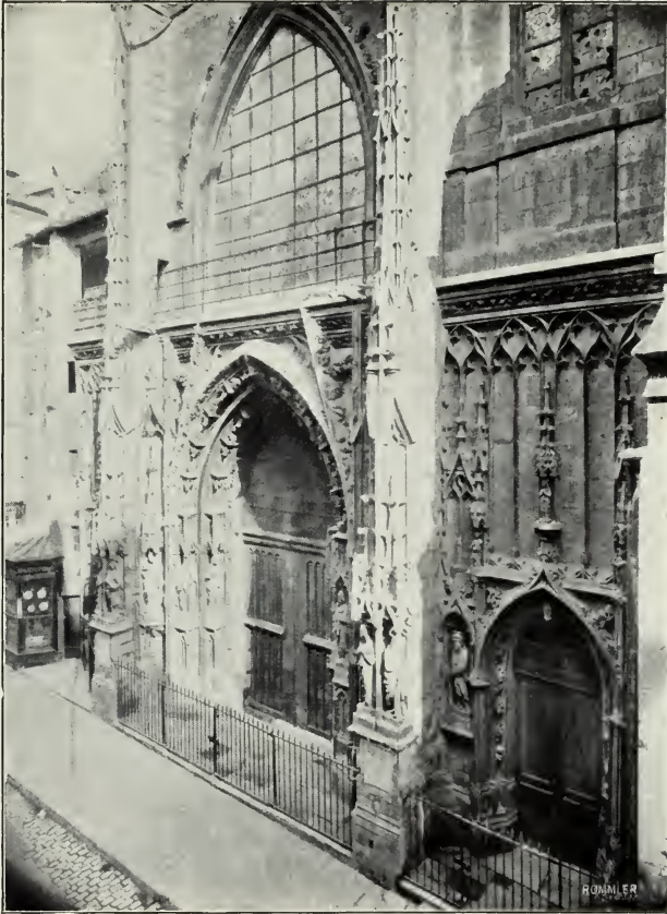
Abb. 38. Kirche St. Merry. Westfassade.
